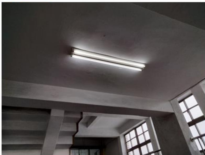
樓梯照明充足
