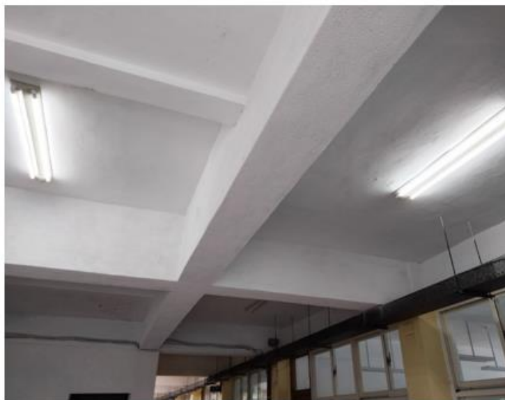
走廊照明充足
